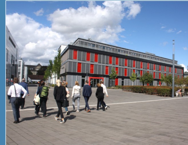
Die Besichtigungsgruppe der Campus-Tour auf dem Weg zum Institut für Ernährungs- und Lebensmittelwissenschaften (IEL); ein erster Blick auf eines der neuen Gebäude.
