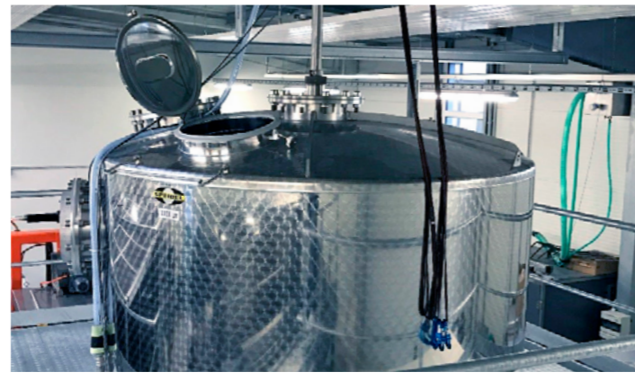
10.000-Liter-Edelstahltank im Technikum des Fraunhofer-IVV Dresden: Tankansicht von Wartungsplattform.
